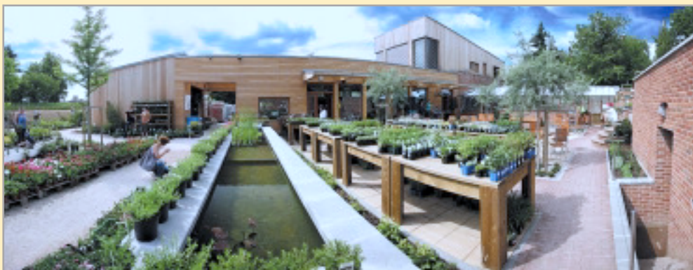
Současný stav po rekonstrukci
