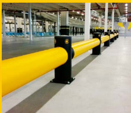
iFlex Single Traffic Barrier vymezuje trasy manipulační techniky v nově vybudované balírně.
