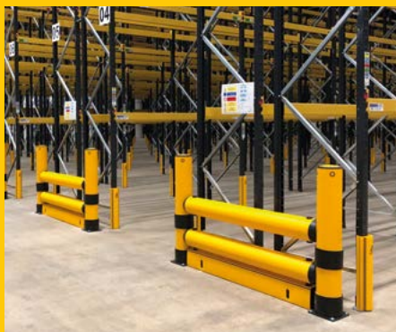
Atypické provedení šířky a nárazové výšky pro konce regálových uliček.
