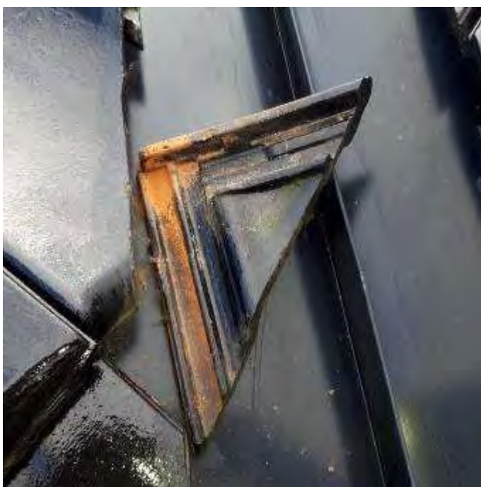
Takovýto přířez tašky v úžlabí jen položený na oplechování nemá šanci setrvat v původní pozici
