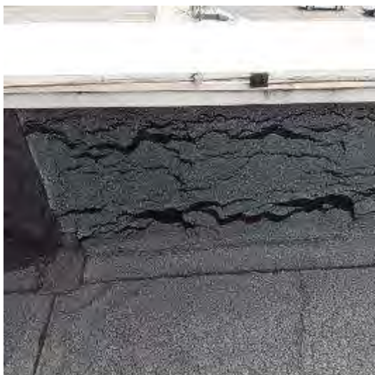
Obr. 1 – degradující asfaltový pás
