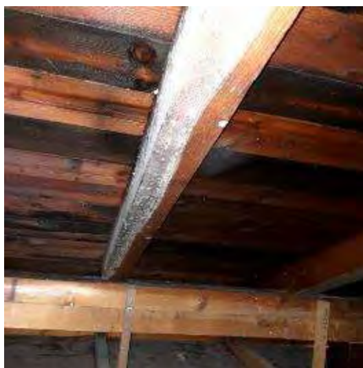
Obr. 2 – plesnivý trám po zatečení
