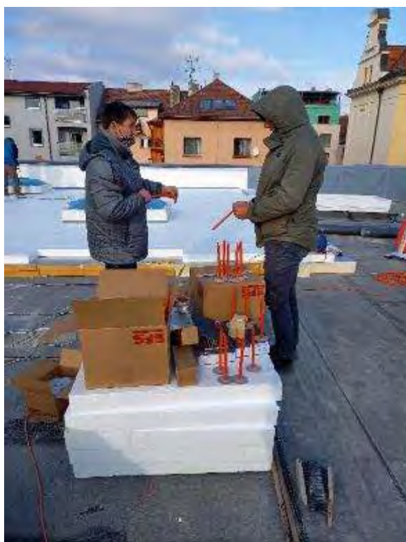
Obr. 3 a 4 – příprava kotev, včetně navlečení papírové podložky, která je nutná při montáži na EPS
