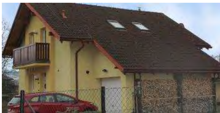
Střeška s betonovou taškou s posypem BRAMAC Alpská.
