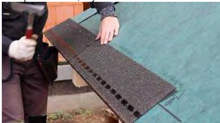
Nainstalovaný podkladní pás a zakládání první řady šindele
