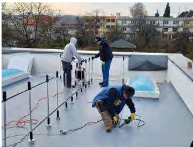
Obr. 10 a 11 – samotné indukční vaření folie k podločkám a následné svařování v přesahu
