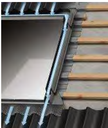
Obr. Ukázka osazeného lemování včetně hydroizolační folie
