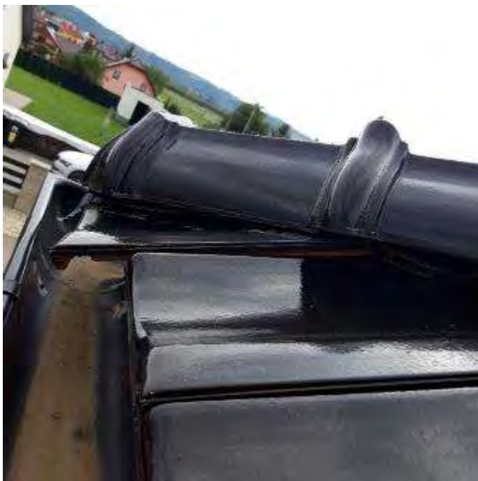
Nepřichycené tašky se posouvají z montážní pozice
