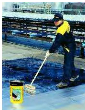
Obr. 4 - ukázka aplikace Reflexolu SA 23 pomocí kartáče
