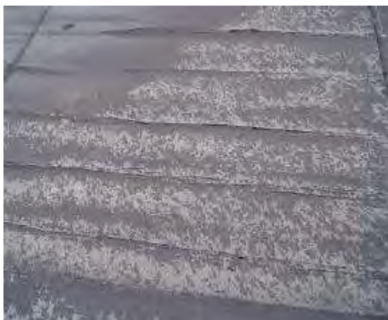
Obr. 1 – ukázka popraskaného asfaltového pásu
