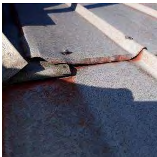
Obr. 3 – vytažení kotevních prvků plechové krytiny
