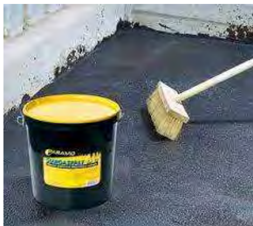
Obr. 2 – ukázka aplikace Gumoasfaltu SA 12 pomocí kartáče
