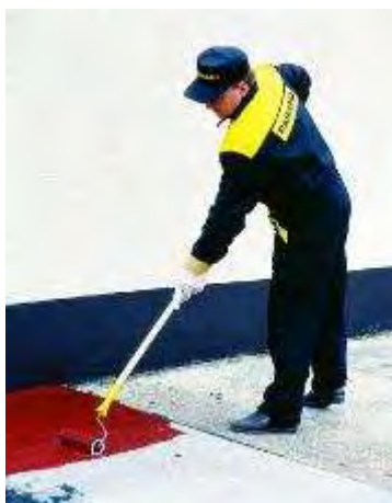
Obr. 3 - ukázka aplikace Gumoasfaltu pomocí válečku
