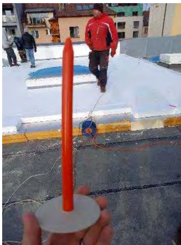
Obr. 3 a 4 – příprava kotev, včetně navlečení papírové podložky, která je nutná při montáži na EPS
