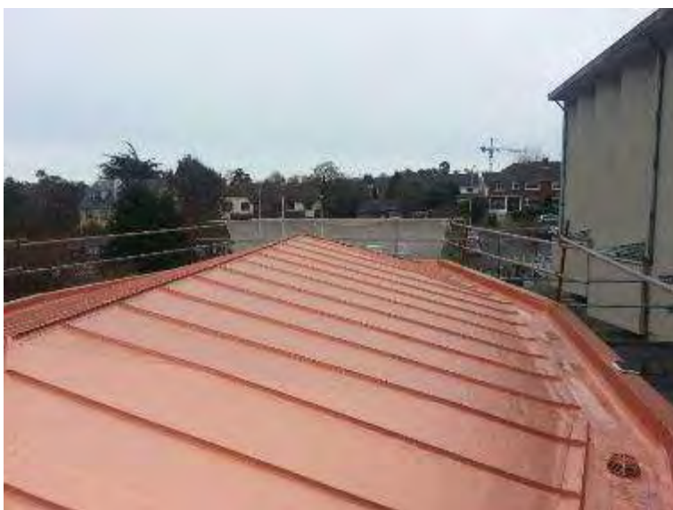
PIB fólie s dekorací profilem opatřená nátěrem obsahujícím měď.
