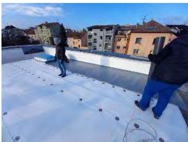
Obr. 8 a 9 – pokládka fólie na nakotvený podklad
