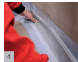
4 Odměřit požadovanou délku pásu a vložit do hydroizolačního nátěru.
