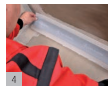
Odměřit požadovanou délku pásu a vložit do hydroizolačního nátěru.
