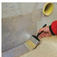
2 / Penetrace podkladu a sjednocení savosti.
