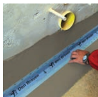
10 / Do prvního nátěru vtlačit Těsnicí pásy a rohy.
