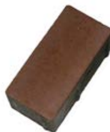
Povrch dlažby bez vápenného výkvětu
