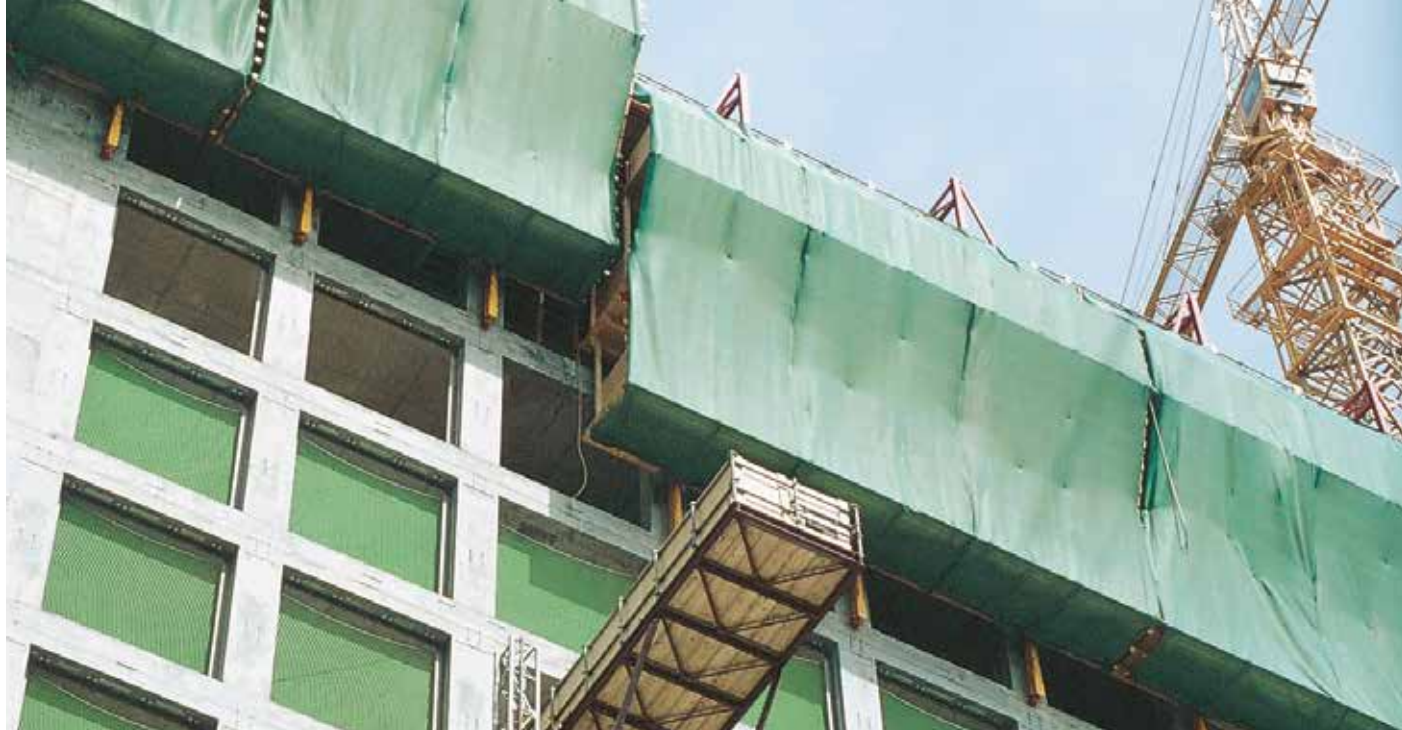
Zajištění těžkými bočními bezpečnostními sítěmi a prodyšnou PE plachtou (200 g/m 2 ) při stavbě Japonského centra ve Frankfurtu ①
