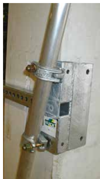
Typ (C) + (D) zajištění okrajů střechy
