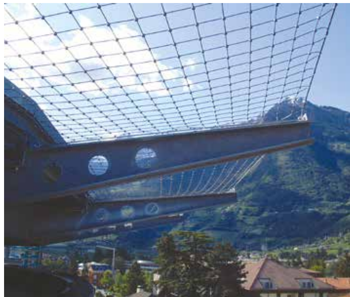
Dralo® jako zajištění venkovního prostoru přistávací plochy vrtulníku v nemocnici v Meranu
