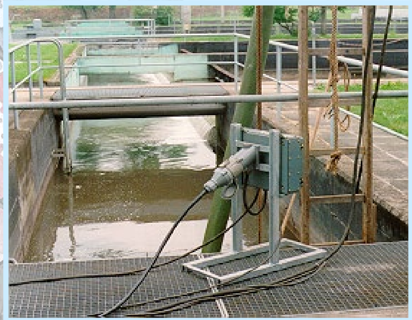
Připojení pohyblivých ponorných čerpadel DS3, 50A, 400V 6+PE+3 pom. kontakty
