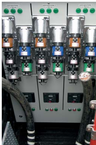
Obr. 4 Jednopolové připojení tří soustav (SP4 – 1000 V AC /1500 V DC/, 700 A)
